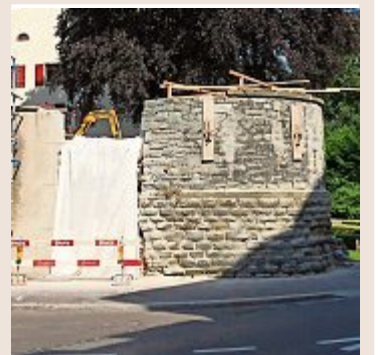
Die Sanierung der Arboner Schlossmauer soll noch dieses Jahr vollendet werden.
